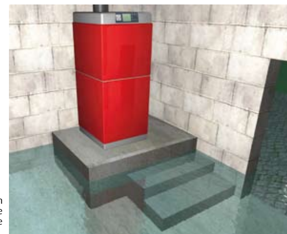
Protection d'un équipement de chauffage par surélévation.
